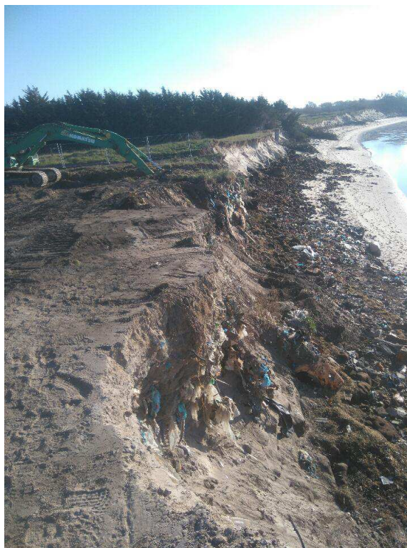
5décembre 2016 : lancement des travaux de nettoyage et de confinement
