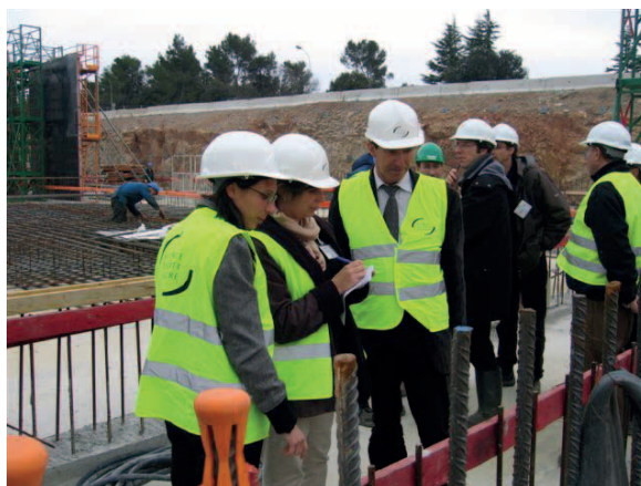
Inspection de l'ASN sur le chantier de construction de l'installation MAGENTA à Cadarache – Avril 2008
